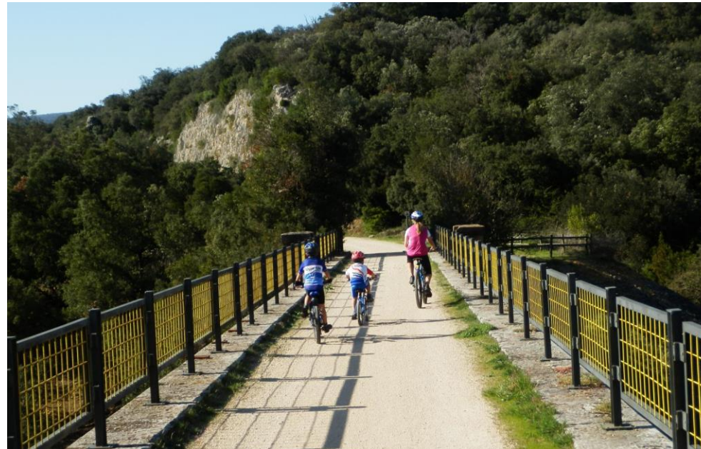
Vía Verde del Ferrocarril Vasco Navarro
